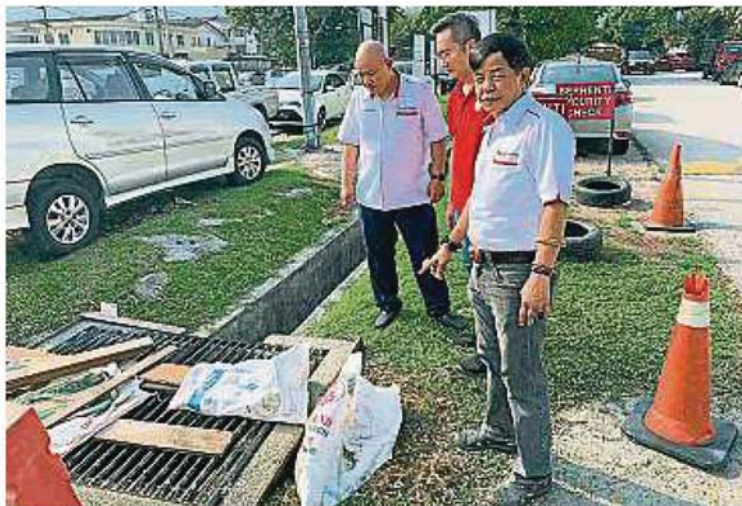
黎濼福（中）巡视隐藏危机的沟渠，左为蔡耀宗。
